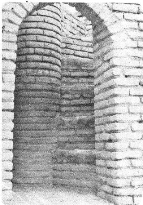
عکس شماره ۲۰ : پایه مناره سردر ورودی - ورامین نمایش راه پله و میله مدور وسط مناره که با آجر تراش ساخته شده است .
