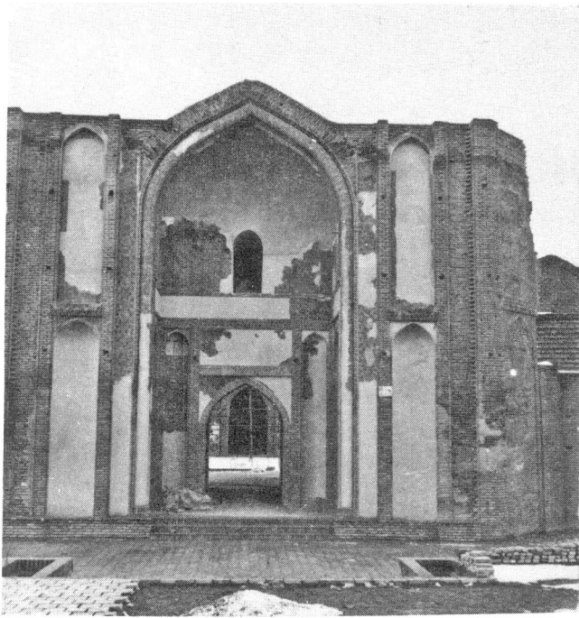
عکس شماره ۴ : سردر ورودی - ورامین نمایش جزئیات ساختمان و تزئینات سردر .
